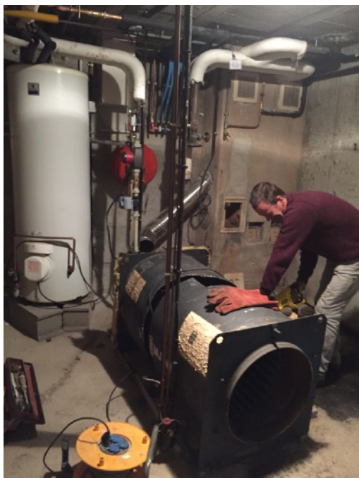
démontage de l'ancienne chaudière
