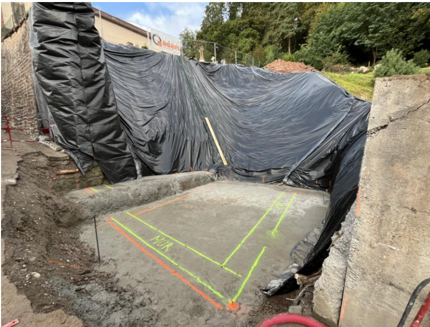
Mise en place de béton dit « de propreté »
